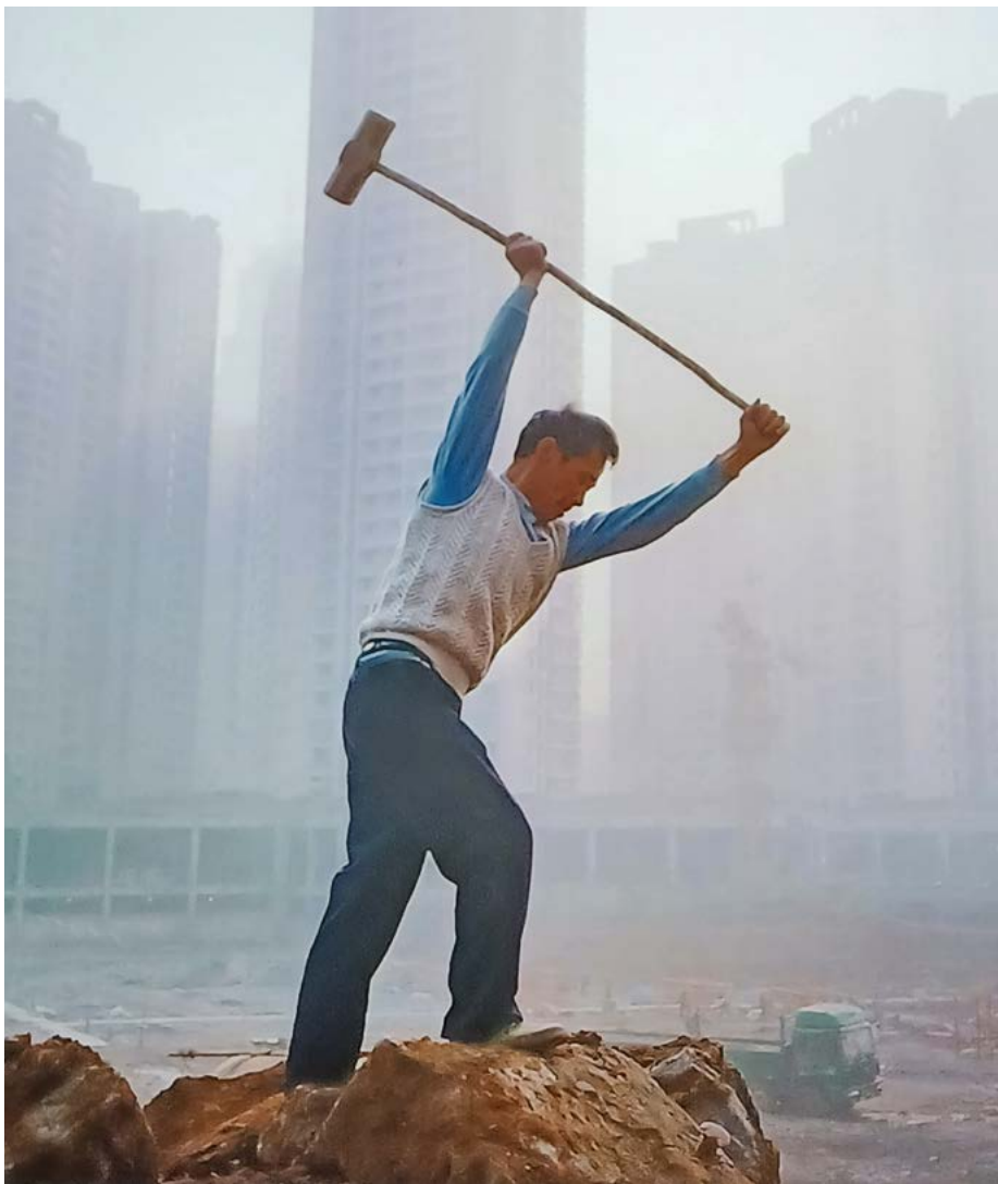
Das Bild erinnert an den Holzfäller von Ferdinand Hodler. Herr Xian aus der Stadt Luzhou bereitet eine Baustelle für einen Neubau in Chongqing vor und zerstört das Alte. Alle Bilder: Andreas Seibert
